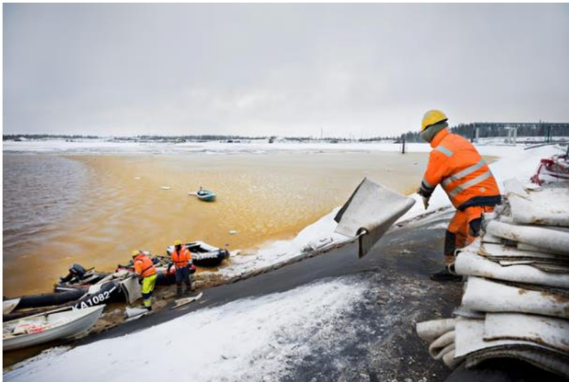
Marraskuussa 2012 Talvivaaran kaivoksen vuotavaa kipsisakka-allasta yritettiin paikata bentoniittimattojen avulla. Altaan eristeenä ollut muovikalvo kuitenkin repesi ja ympäristöön pääsi virtaamaan suuri määrä suola- ja metallipitoista vettä. Kuva: Miska Puumala
