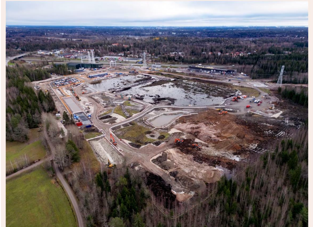
Datakeskusten vuotuinen sähköverotuki voi nousta suuremmaksi kuin mitä monilla hallituksen leikkauksilla saadaan säästöjä. Kuvassa Microsoftin rakenteilla oleva datakeskusryhmä Espoon Pihlajärinteentä Kehä III:n varrella. Kuva: Mika Ranta / HS
