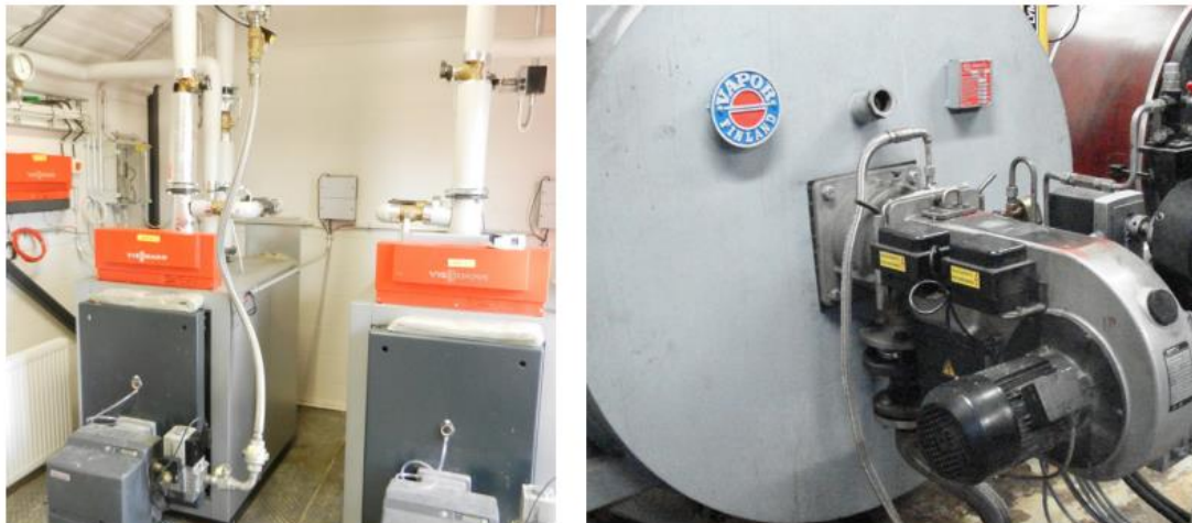
Kuva 46. Biokaasukäyttöisiä kattiloita: a) Kaksi 90 kWt lämpökattilaa ammattiopisto Lappian Tervolan yksikön keskuslämmitysjärjestelmässä. b) 1,4 MWt :n kattila teollisen prosessilämmön tuotantoon. (Kuvat: Ari Lampinen) [9]
