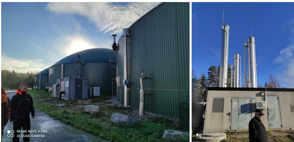
Kuva 16. Jepuan biokaasutuotantolaitos (märkämädätys) ja biokaasun puhdistusyksikkö. (Kuvat Tapio Patrikainen)
