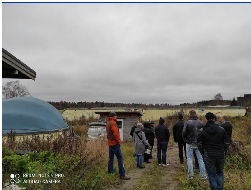
Kuva 18. Metener Oy:n kuivamädätyslaitos keltainen edessä näkyvä säiliö ja vasemmalla kostutusliuoksen pumppaamo ja kaasun keräys.(kuva Tapio Patrikainen)
