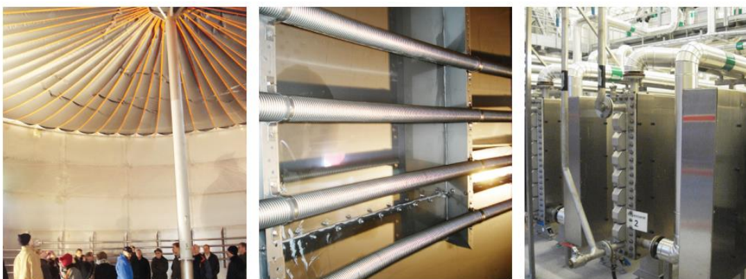
Kuva 48 7.10 Biokaasureaktorin lämmitysputkistoa Biokympin laitoksella Kiteellä (vasemmalla ja keskellä) ja hygienisointiyksikön lämmönvaihtimia NSR:n biokaasulaitoksella Helsingborgissa (oikealla). (Kuvat: Ari Lampinen) [9]
