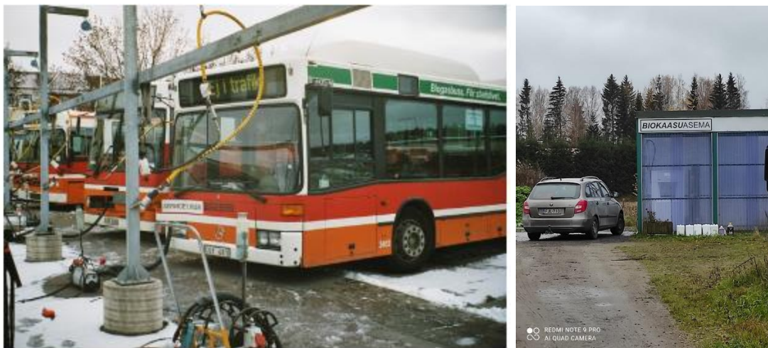
Kuva 52 a) Hidastankkausasema suurella bussivarikolla Linköpingissä. b) Kotitankkausasema Laukaassa. (Kuvat: Ari Lampinen ja Tapio Patrikainen) [9]
