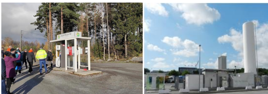
Kuva 51 Nopeatankkausasemia: a) Jepuan tankkausasema. b) LBG+LCBG-asema Göteborgissa (CBG vasemmalla, LBG keskellä). (Kuvat: Tapio Patrikainen ja Ari Lampinen) [9]
