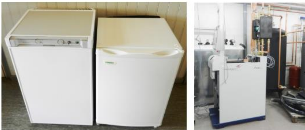
Kuva 54 Biokaasukäyttöisiä absorptiokylmäkoneita: a) Biokaasua polttavia jääkaappeja Haminassa. b) Biokaasusähkön tuotannon hukkalämpöä tilojen viilennykseen hyödyntävä absorptiolämpöpumppu Kouvolan seudun ammattiopiston Biosampo-koulutuskeskuksessa Anjalassa. (Kuvat: Ari Lampinen) [9]
