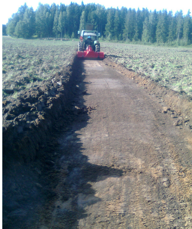
Bild 3. Vid kortare sträckor kan man flytta jord med hjälp av ett schaktblad. Genom att göra en "ränna" av jordvallar kan man göra arbetet effektivare. Bild: Tuomas Mattila.
