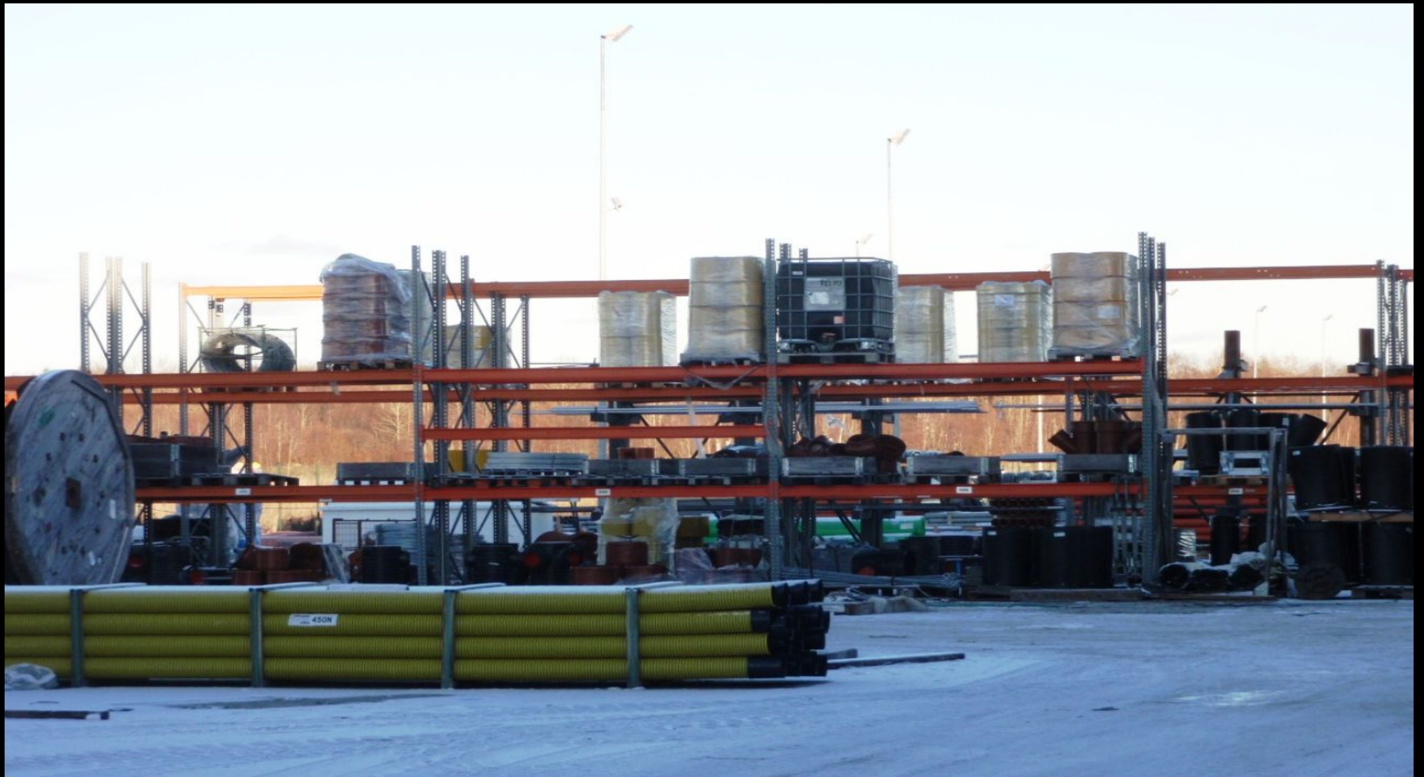
Склади під відкритим небом (Uncovered outdoor storage, Photo taken from Logistiikanmaailma website)
