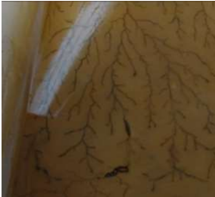
Kuva: Sähköpuu eristeessä.
