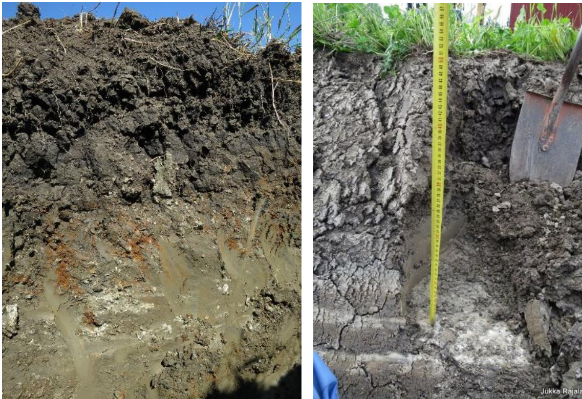
Kuva 5. Syvämpi maaprofiilin tarkastelu paljastaa maan vedenläpäisykyvyn. Vasemmalla erittäin tiivis pohjamaa, oikealla noin 0,5 m syvyydessä on kolme kerrosta, jotka eivät läpäise vettä. Kuvat: Jukka Rajala
