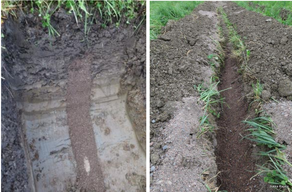
Kuva 6. Tarvittaessa täydennysojitus soralla täytetyin salaojin varmistaa hyvän kuivatuksen. Veden pääsyä salaojiin voidaan tällöin edelleen nopeuttaa poikittain tehtävällä jankkuroinnilla tai myyräojituksella. Kuvat: Jukka Rajala
