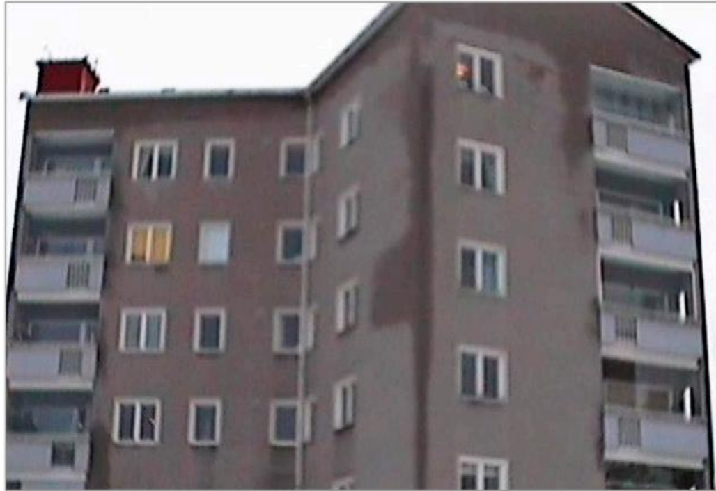
Kuva 3.12. Viistosateen aiheuttamaa lämpötila- ja kosteusvaihtelua rakennuksen julkisivulla. Lämpökuvissa näkyy havainnollisesti kuinka nurkka-alueet ja päädyt ovat muuta julkisivua kylmempiä alueita. Lisäksi yhden asunnon kohdalla on tehty lisälämmöneristys sisäpuolelta. Seinä ei kuivu enää yhtä nopeasti kuin eristämätön seinä. Kuvat: P. Räisänen, Vahanen Oy.
