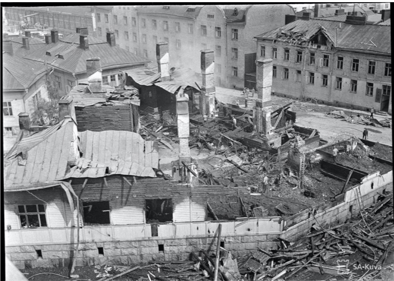
Bild 2 Bild av bombningen i Helsingfors. Arbetarnes i Helsingfors Byggnads Aktiebolag, de s.k. Borgågatans hundra marks villor. I förgrunden Borgågatan 1 och 3, i bakgrunden Flemingsgatan. Fotograf Lehtinen, Krigsmuseet. 9.7.1941. Användarrätt till bilden CC BY 4.0. Finna.fi: Länk till sidan med bilden.
