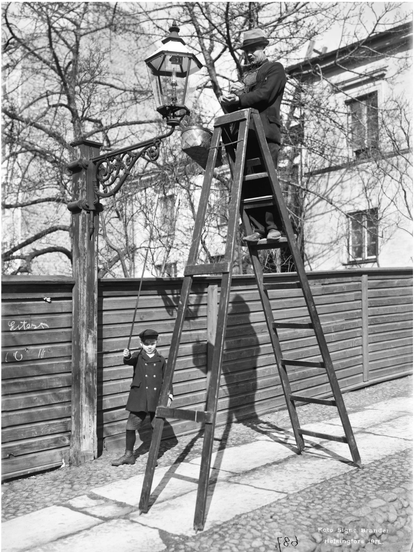
Bild 5 Rengöring av en gasdriven gatlykta invid Konstantinsgatan (Sjötullsgatan) 10. Fotograf Brander Signe, Helsingfors stadsmuseum 1912. Användarrätt till bilden CC BY 4.0. Finna.fi: Länk till sidan med bilden.
