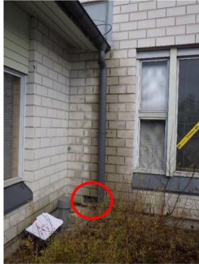
Kuva 191. Rakenneavaus RA-US2 tehtiin ulkoseinän US4 kastuneen julkisivun kohdalle.
