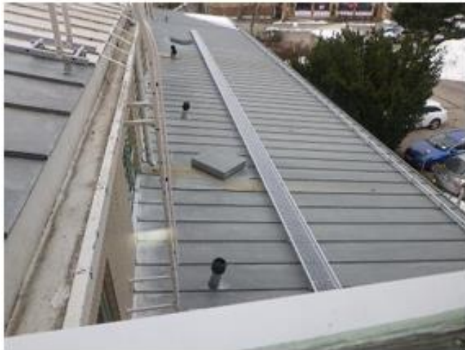
Kuva 131. Rakennuksen osan I vuonna 2017 uusittu konesaumattu peltikate. Vesikatetta ei ole maalattu.
