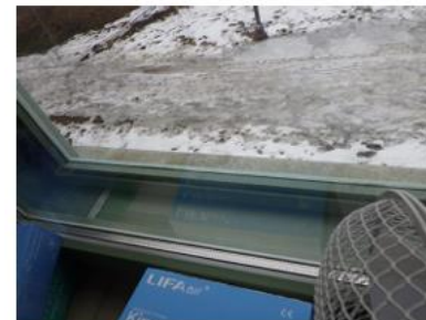
Kuva 87. Pohjoissivun sisäpuolen ikkunapuitteiden ja karmien maalipinta on hyväkuntoinen. Kuva pohjoissivun ensimmäisen kerroksen ikkunasta.
