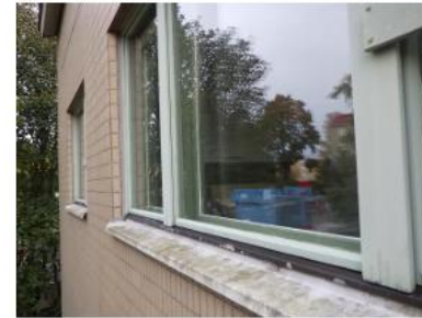
Kuva 85. Pohjoissivun kolmannen kerroksen ikkunat ovat tyydyttävässä kunnossa. Ikkunoiden puupuitteiden ja peitelistojen maalipinta ei vaadi välitöntä huoltomaalausta.
