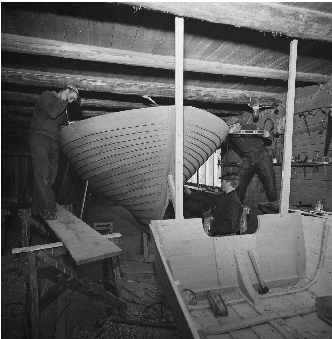
Kuva 12 Veneenveistoa Virolahdella. Kuvaaja Kyytinen Pekka, Museovirasto 1962. Kuvan käyttöoikeus CC BY 4.0. Finna.fi: Linkki kuvan sivulle.
