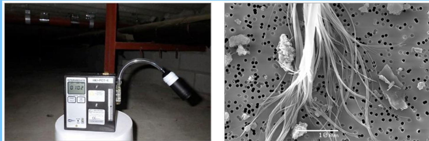
Kuva 3.19. Vasemmalla ilmanäytteenotto asbestianalyysiä varten. Näyte otettiin rakennuksen käyttötilojen ulkopuolisesta tilasta, jonka rakenteissa oli käytetty asbestipitoisia kuitusementtilevyjä. Oikean puoleisessa kuvassa krysotiiliasbestikimppu elektronimikroskooppikuvassa. Kuvat: T. Poutiainen ja J. Säntti, Vahanan Oy
