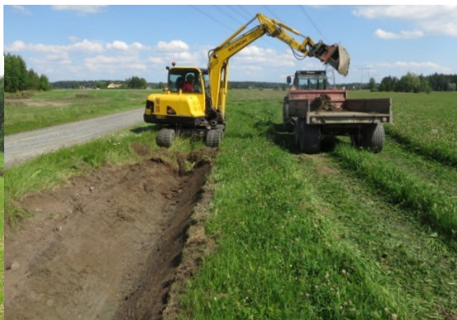
Kuva 4. Reunaojien perkauksessa ojamaat voidaan ajaa notkelmiin ja tasata pelto tämän jälkeen. Kuva: Jukka Rajala.
