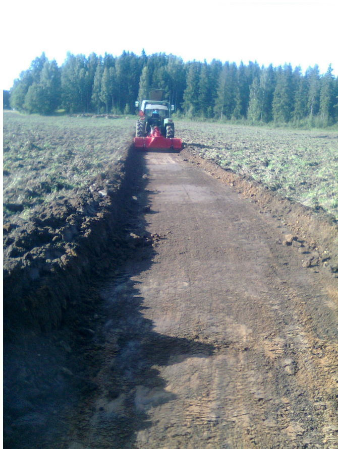
Kuva 3. Lyhyille matkoille maansiirto sujuu perälevyllä. Siirtoa tehostaa, kun siirtoa varten tekee ”rännin” maavaleista. Kuva: Tuomas Mattila.
