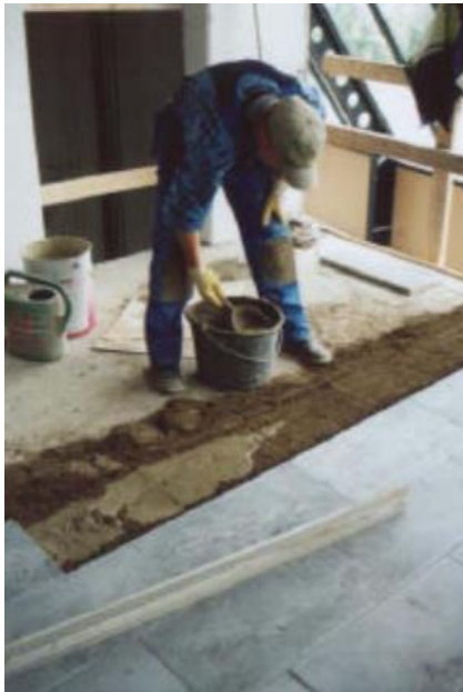
MAAKOSTEALLA BETONILLA JA LIMULLA (sementti-vesiseos, sementtiliima) LAITETTAVAT KIVILAATAT (Lähde: Kiviteknologia sivusto)
