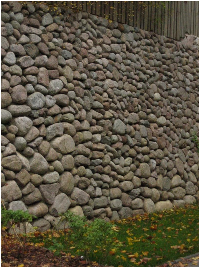
pulteri/seulanpäämuuri (tukimuuri)
