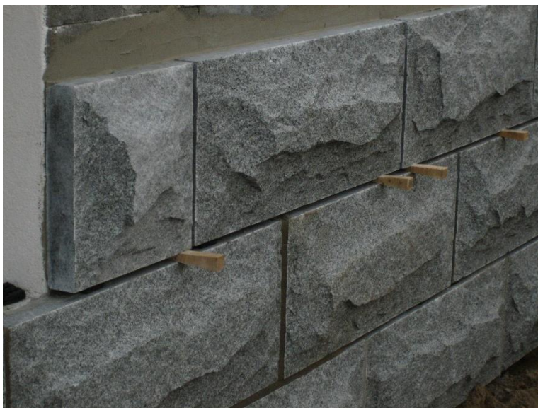
sokkeliin ulkotiloissa, asennus kiiloilla, osassa saumaus
