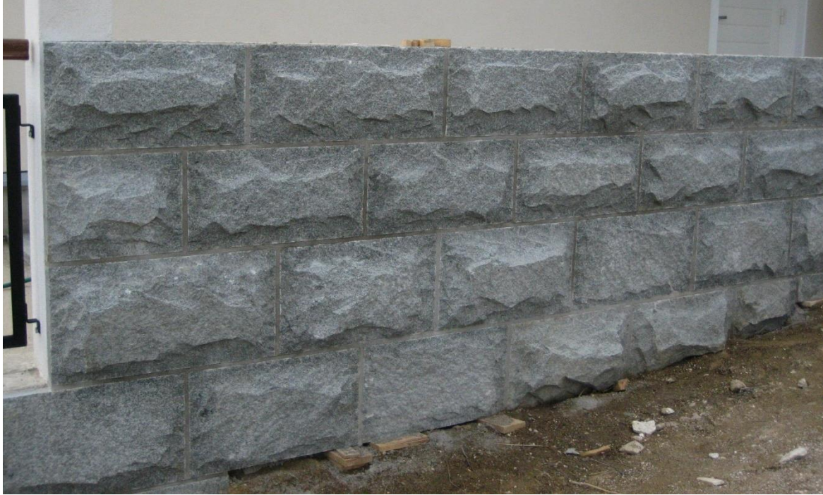
lohkolaatta sokkelissa ulkotiloissa laastilla kiinnitettynä ja saumattuna
