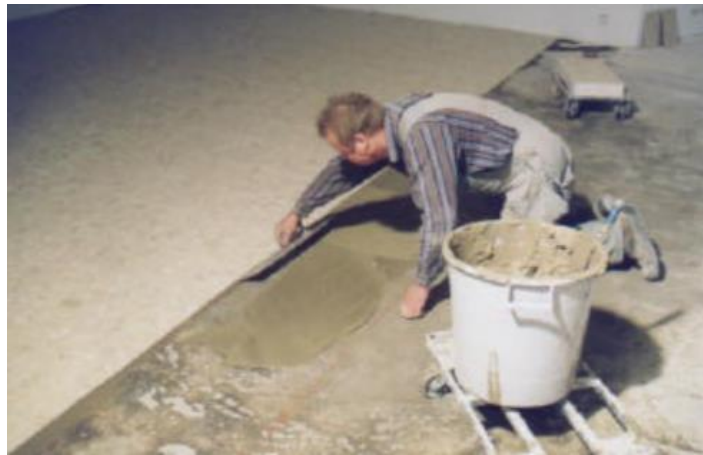
LAASTILLA (saneerauslaasti, klinkkerilaasti) LAITETTAVAT KIVILAATAT
