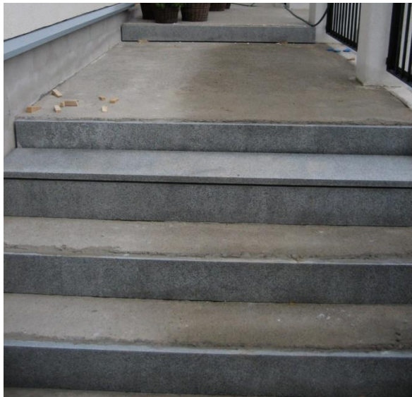
portaat graniittilaatasta laastilla kiinnittäen
