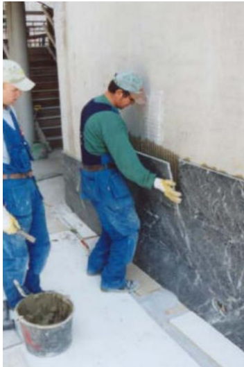
LAASTILLA (saneerauslaasti, klinkkerilaasti) LAITETTAVAT KIVILAATAT
