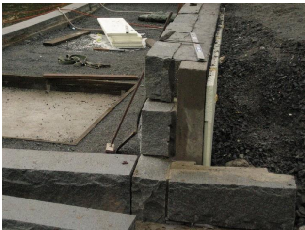
muurikivet anturassa, eristys, täyttö
