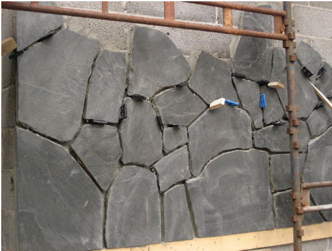
kiinnitys seinään, vapaa saumaväli ilman saumausta
