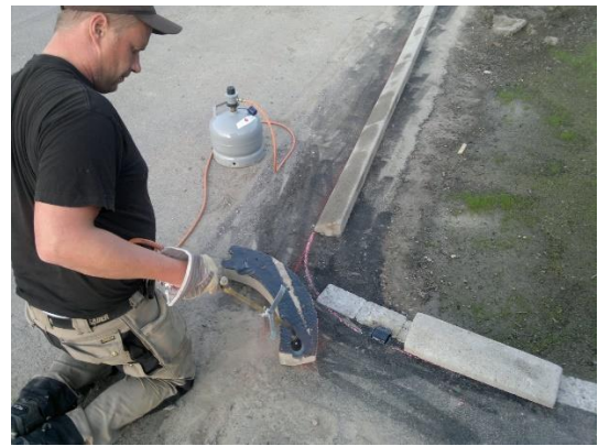
TOHO, NESTEKAASUPOLTIN (LÄMMITYS/SULATUS, BITUMILIIMAUS)
