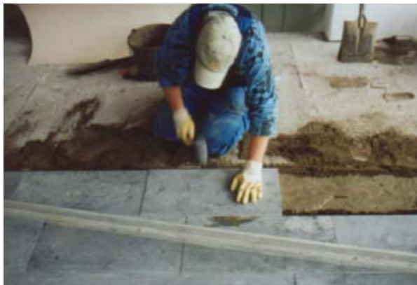
MAAKOSTEALLA BETONILLA JA LIMULLA (sementti-vesiseos, sementtiliima) LAITETTAVAT KIVILAATAT (Lähde: Kiviteknologia sivusto)
