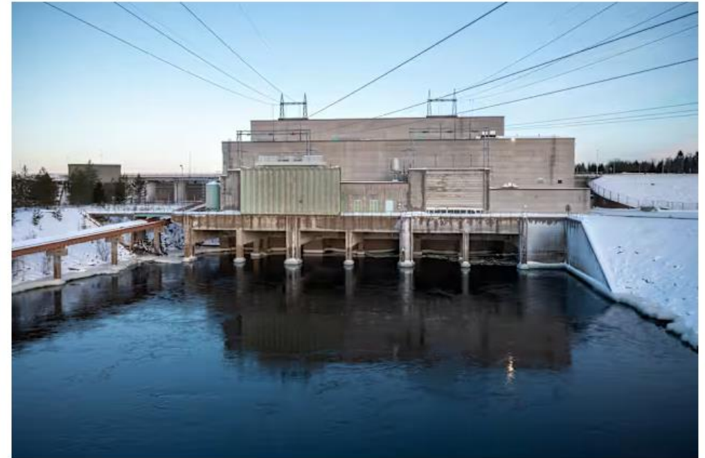
Vesivoimayhtiöt ovat keskeisessä asemassa, kun puhutaan jokivesistöjen tilasta. Kemijoki oy:n Taivalkosken voimalaitos Keminmaassa kuvattuna tammikuussa 2022. Kuva: Antti Ullakko / Yle
