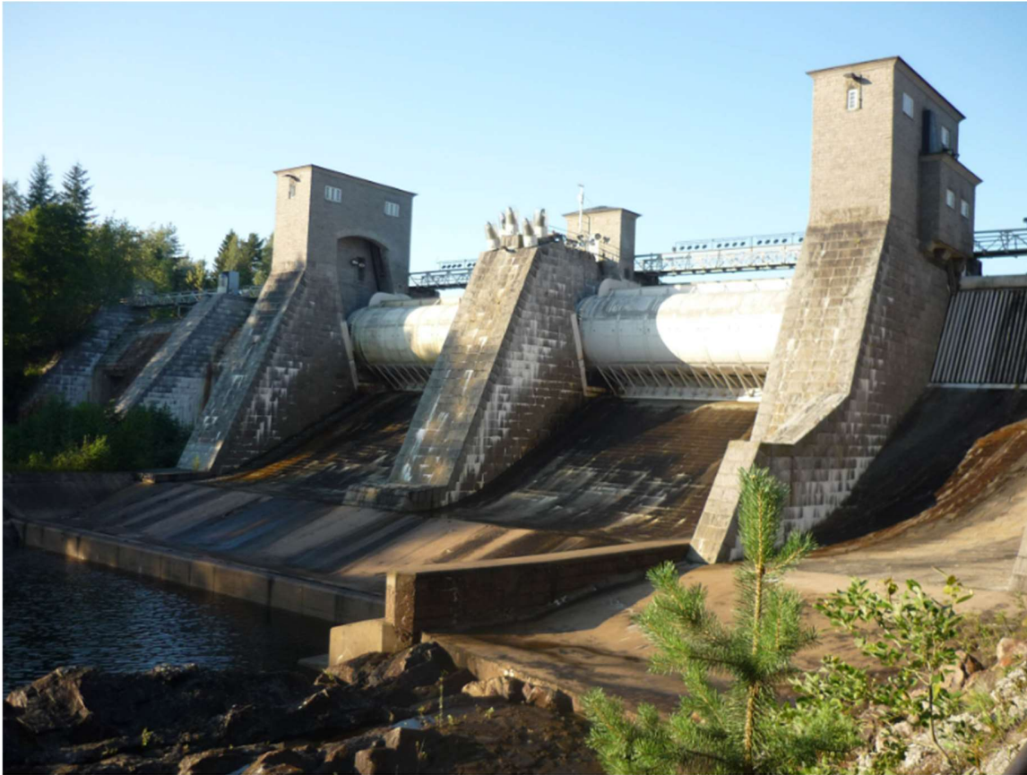
Kuva 2. Suomen suurimpiin kuuluvan Imatrankosken vesivoimalaitoksen patovalli 18.8.2012. [tietoa Suomen- vesiputouksista/vesiputoukset ja vesivoima Suomessa].
