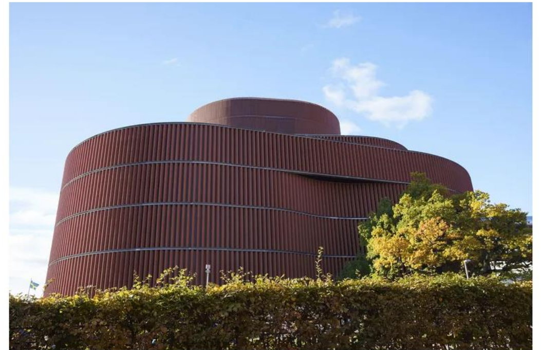
Länsinaapurissa. Pilottilaitos sijaitsee Värtaverket-voimalassa Tukholman Hjorthagenissa. KUVA: EVELINA CARBORN
